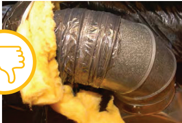
EL DUCTO FLEXIBLE ESTÁ BIEN SUJETO AL DUCTO DE METAL
