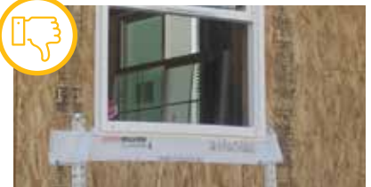
Ventana con tapajunta instalada inapropiadamente.
