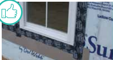
Ventana instalada apropiadamente con tapajuntas para el clima.
