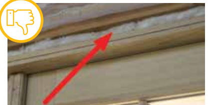
Barilla de respaldo y masilla completando el sello alrededor del marco de la ventana.
