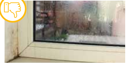
Ventana con condensación por falta de aislamiento.
